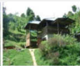
รูปที่ 3.2 บ้านเรือนตั้งอยู่บนดินถล่มจึงไม่ปลอดภัย บ้านดินสองฝั่งห้วยน้ำพญาชั้นดินเหนียวมีรอยร้าวดินถล่มในฤดูฝน
