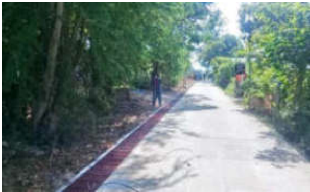
วางระบายน้ำพร้อมตะแกรงเหล็กหมู่ที่ ๘
