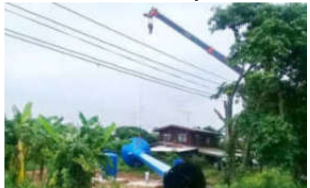
ติดตั้งถังแชมเปญ หมู่ที่ ๙
