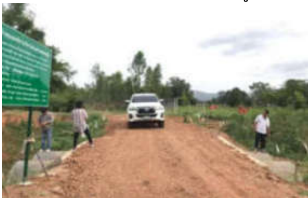
ซ่อมแซม วางท่อหมู่ที่ ๑๐
